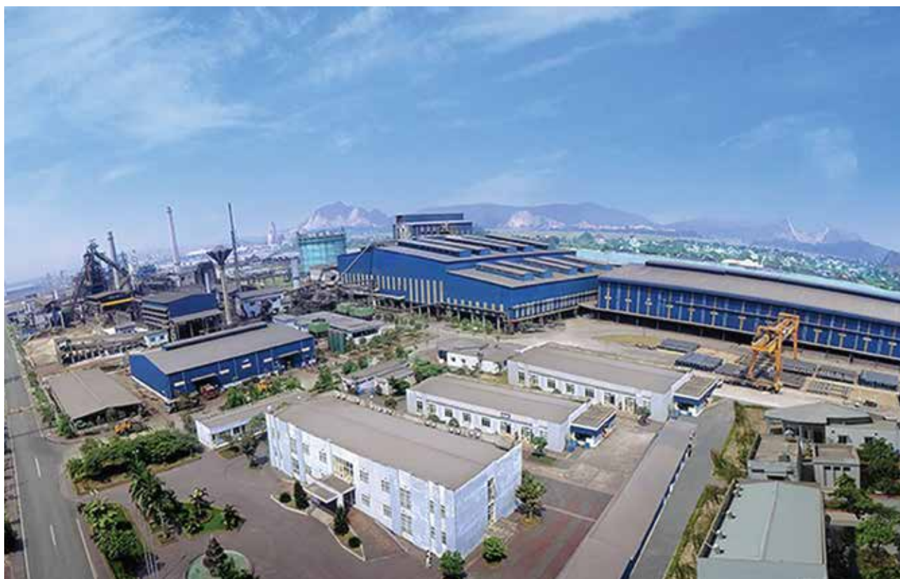
Cung cấp hệ thống THANG MĂNG CÁP cho tập đoàn HOÀ PHÁT tại khu liên hợp sản xuất gang thép Dung Quất Provide a CABLE TRUNKING system for HOA PHAT Group in Dung Quat Iron and Steel Production Complex
