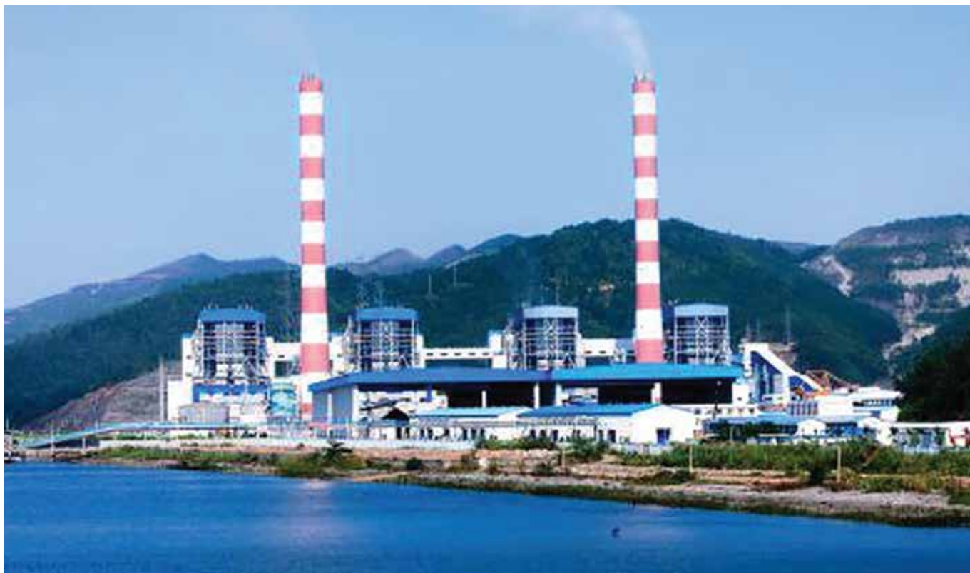
Cung cấp lắp đặt CÂN BẰNG TẢI cho nhà máy nhiệt điện quảng ninh tại TP Hạ Long Quảng Ninh Supply and installation of LOAD BALANCING system for Quang Ninh thermal power plant in Ha Long City
