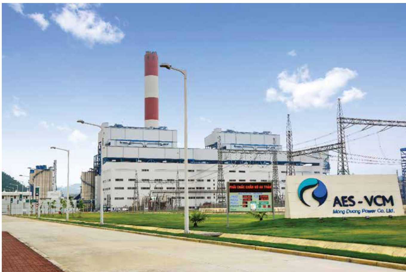
Tư vấn lắp đặt giải pháp tự động hoá cho băng tải than cho nhà máy nhiệt điện Mông Dương tại Quảng Ninh Consult and install automation solutions for coal conveyors for Mong Duong thermal power plant in Quang Ninh
