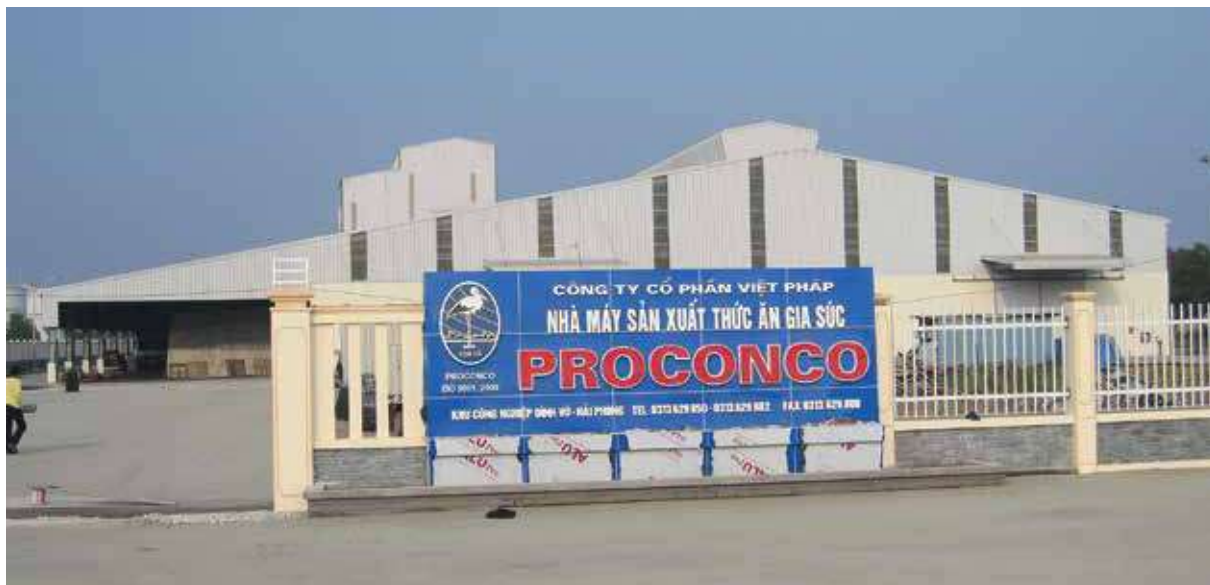
Cung cấp tủ Phân phối nguồn, tủ ATS và tủ TỤ BÙ cho nhà máy PROCONCO tại khu công nghiệp Đình Vũ, Hải Phòng Supply of Main distribution switchboard, Automatic transfer switches and COMPENSATE CAPACITOR cabinets for PROCONCO factory in Dinh Vu industrial zone in Hai Phong
