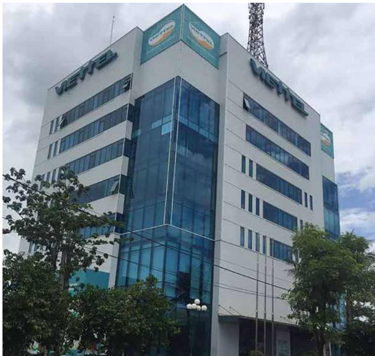
Cung cấp TRẠM BIẾN ÁP và MÁY PHÁT ĐIỆN Dự phòng cho toà nhà VIETTEL tại Ngã tư Hoa Đô, Ninh Bình Provide SUBSTATIONS and backup GENERATORS for VIETTEL building Hoa Do crossroad in Ninh Binh
